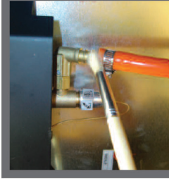
Anschluss des Schlauchs an das Gerät
